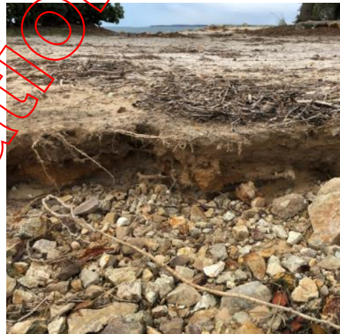
(d) Erosion of sub-base
